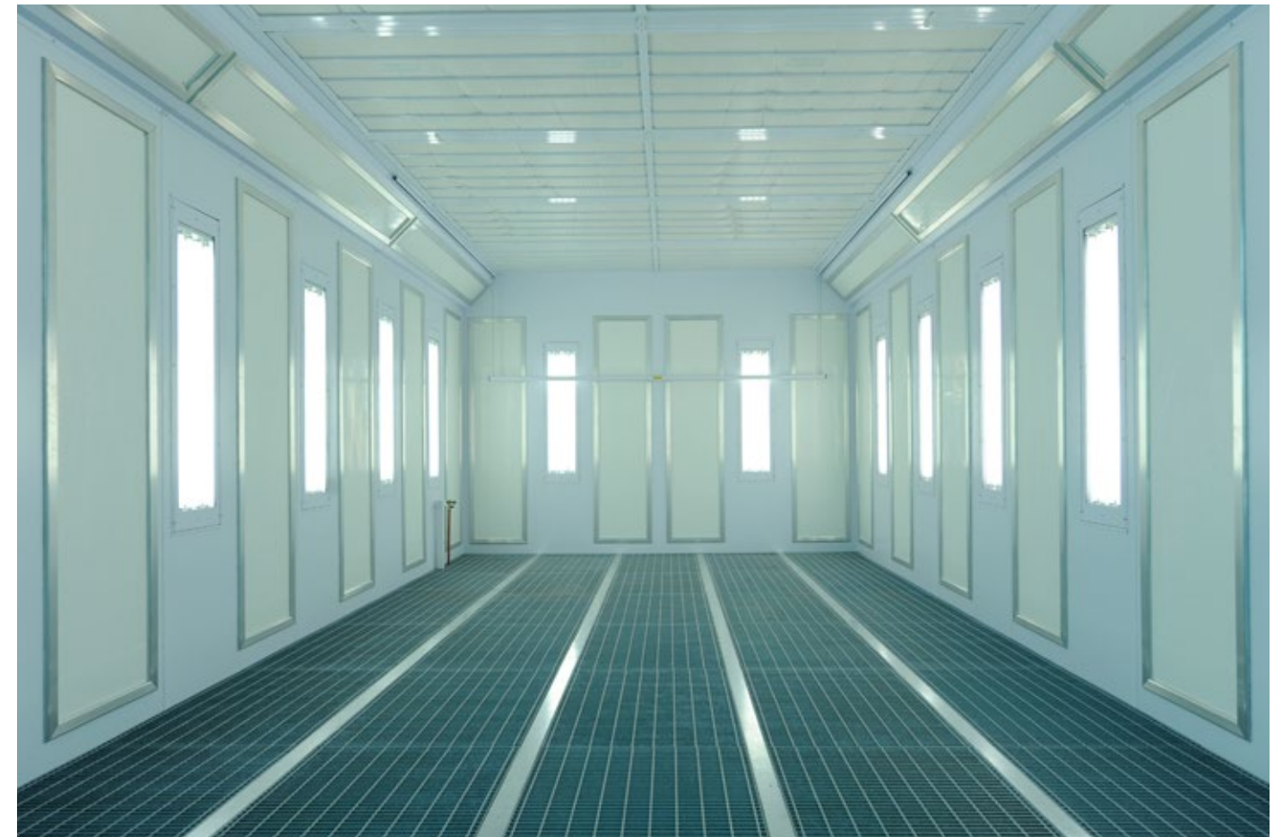
PINTURA Instalação de Cabines de Pintura + Box de Afinação de Tintas
